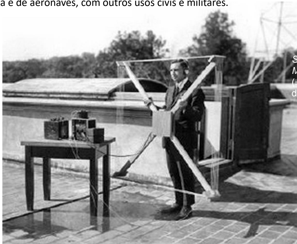
(A) Experimento com uma antena loop para direction-finding em Philadelphia – USA por volta do ano 1918.
